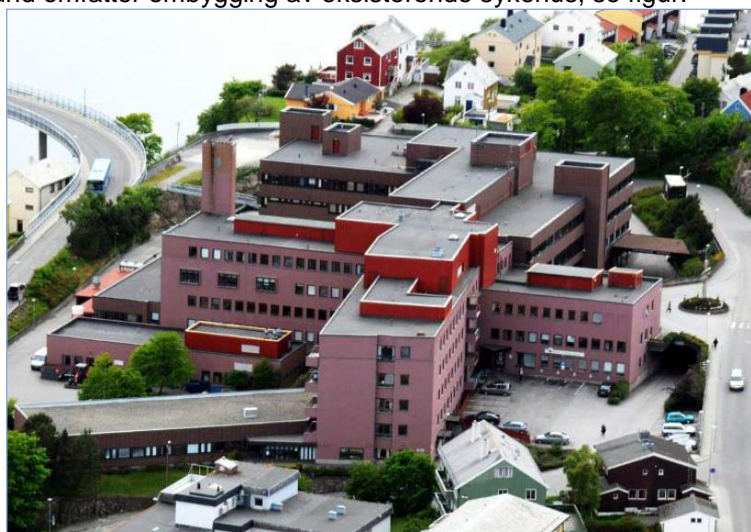
Figur 2-3 Eksisterende sykehus i Kristiansund som skal ombygges
